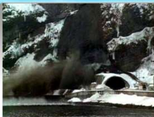
1996年 豊浜トンネル崩落
