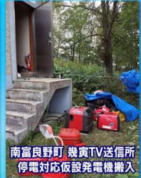
南富良野町 幾寅TV送信所 台風による出向道土砂流出復旧作業
