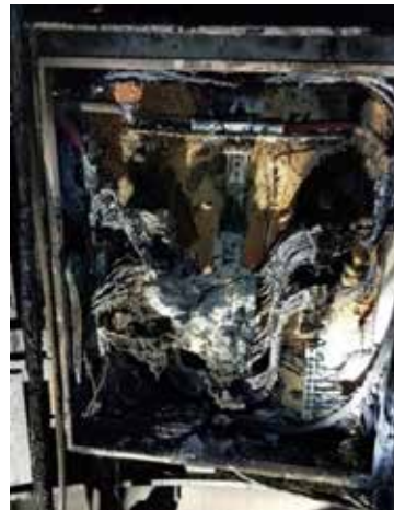
鉄塔内部の様子(左:避雷器基盤の焼損、中・右:放送用ケーブル)
