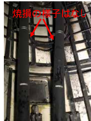
鉄塔内部の様子(左:避雷器基盤の焼損、中・右:放送用ケーブル)
