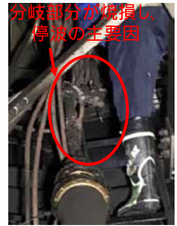
鉄塔内部の様子(左:避雷器基盤の焼損、中・右:放送用ケーブル)
