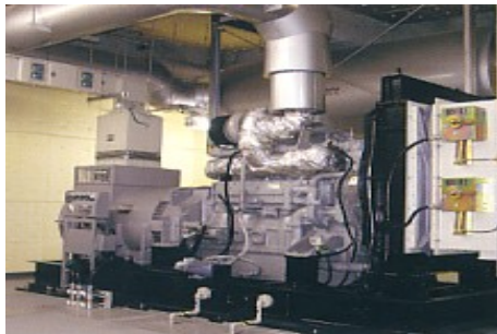
非常用発電機
