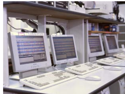
運用監視装置
