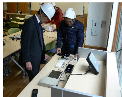
衛星回線、ICTユニットの立ち上げ
