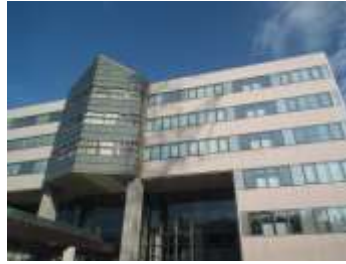
東北電力総合研修センター
