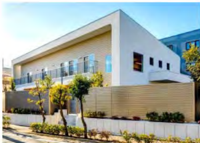
建物外観（北東側から）
