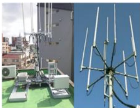
基地局(アンテナの例)
