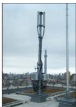
基地局(屋上設置)
