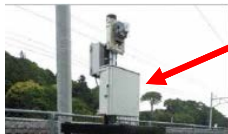
制御ボックス設置（例）
