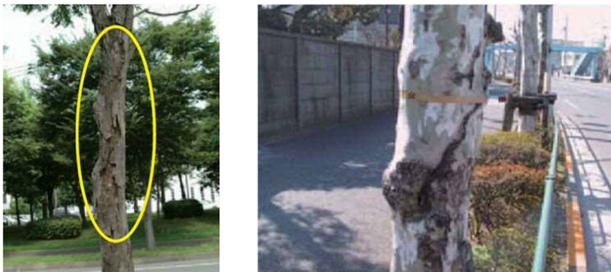
写真 樹皮枯死・欠損 3)
