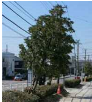
地震液状化による傾斜 8)
