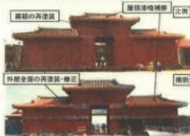
【工事期間】平成27年5月20日～平成28年3月末まで(予定) 【工事内容】外部の再塗装及び補修、屋根葺き補修、裏側再塗装
