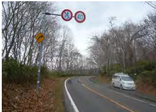
⑥ 支笏湖支所
