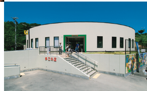
レストラン「まごの店」。建物の設計アイデアは三重県内の工業高校の生徒たちから募集した。
