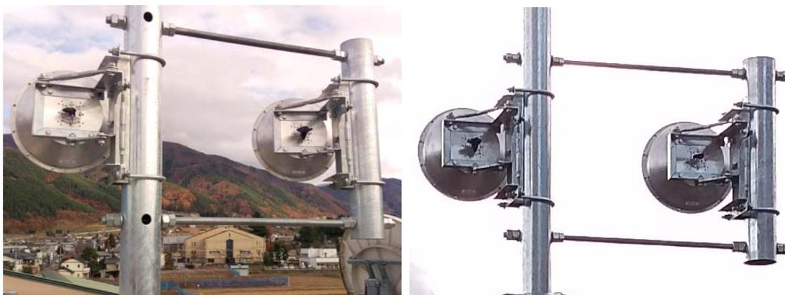
図 4-40 アンテナ取付状況 (左: 親局 (1次) 側 右: 子局 (2次) 側)
