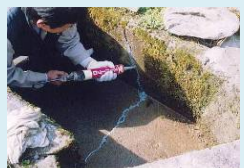
水路のひび割れ補修
