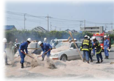
災害復旧作業時の連絡
