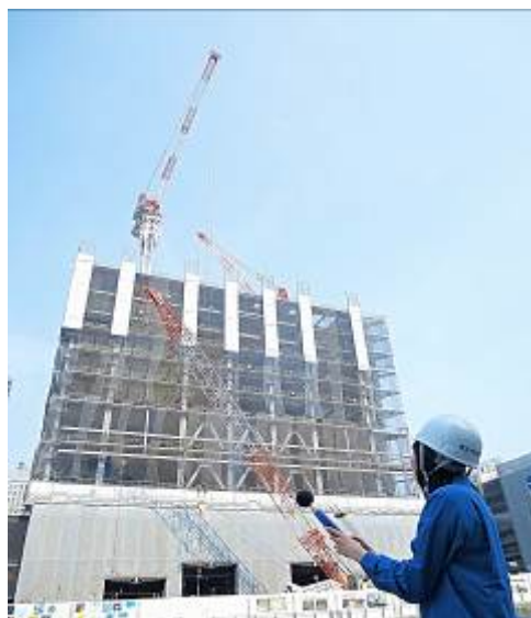
建設中の新市庁舎
