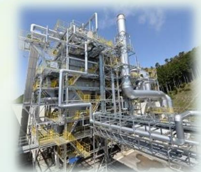
バイオマス発電所
