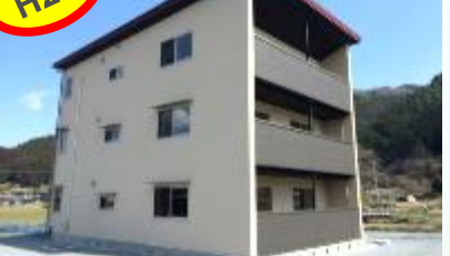
CLTの市営住宅 (H27年4月入所)
