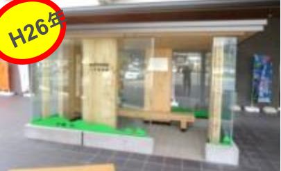
真庭市役所前バス待合所 (国内初のCLT建造物)
