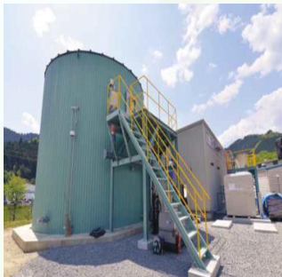
バイオ液肥・バイオガス実証プラント
