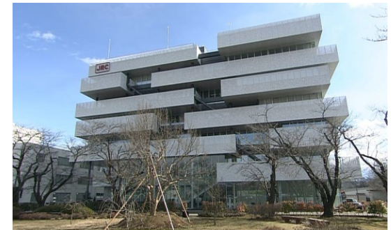
日本無線(株)先端技術センター
