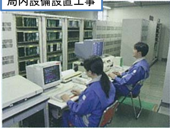
局内設備設置工事
