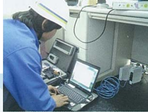
ビル内配線工事
