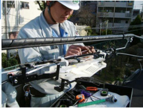
光クロージャ接続工事
