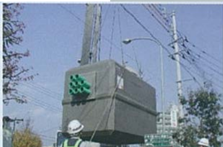
マンホール設置工事
