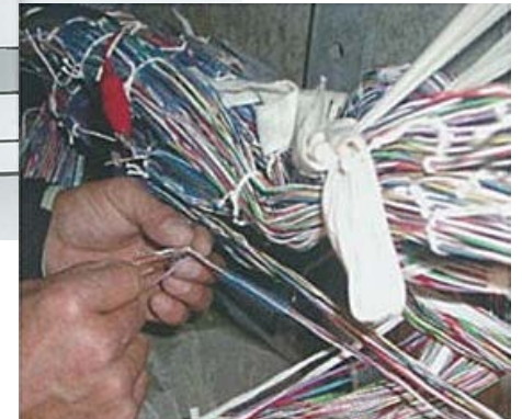
ケーブル接続工事
