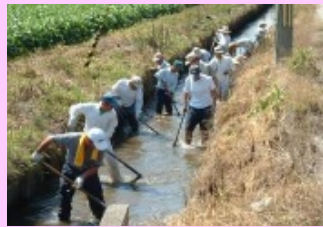
水路の泥上げ
