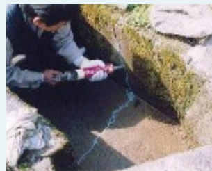
水路のひび割れ補修
