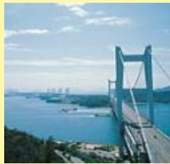
瀬戸大橋(倉敷市)
