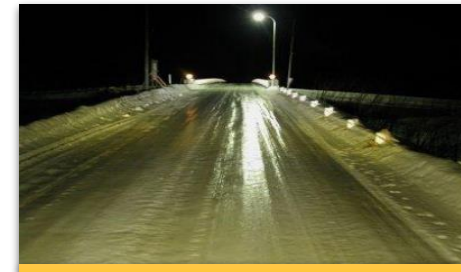
非常に滑りやすい路面凍結道路 国土技術政策総合研究所 研究資料より
