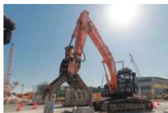
「5G」・4K3Dモニターを活用した 建機の遠隔施工
