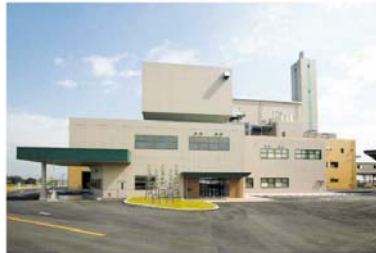
西濃環境保全センター(溶解炉)
