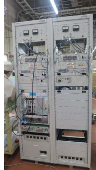
中継局用送信設備 (名古屋地区)
