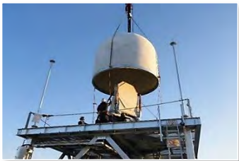
埼玉大学設置完了
