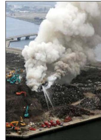
仮置場の面積不足のために高く積み上げられた災害廃棄物が、圧密・腐敗・発酵により温度が上昇し、火災が発生
