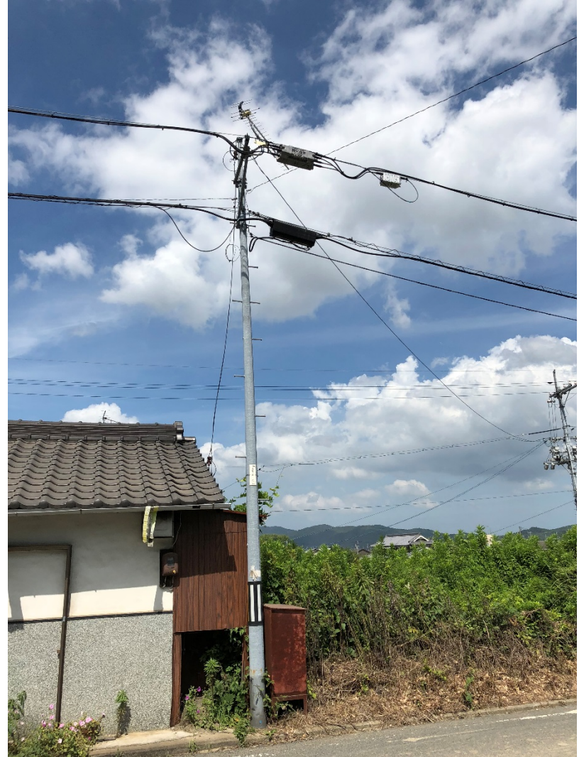
幹線アンプ途中区間へのつなぎ込み
