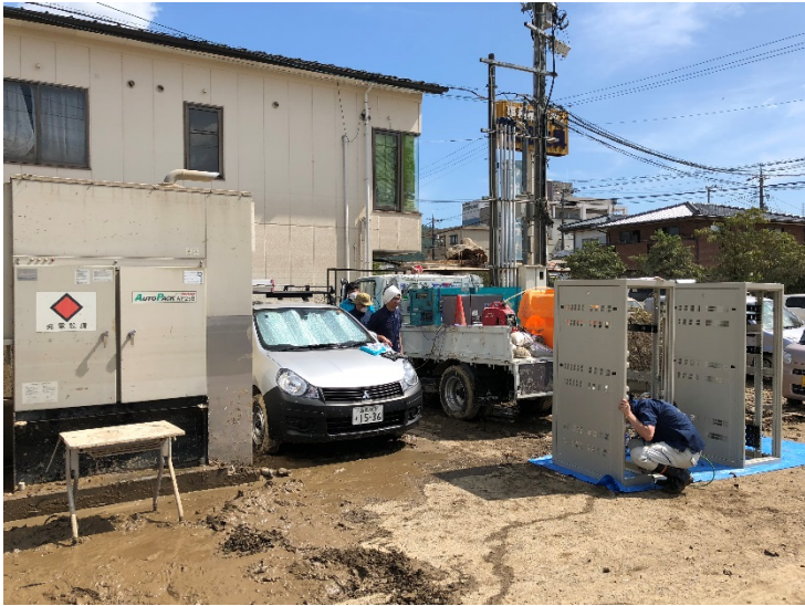
機器ラック洗浄
