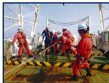
断線した海底ケーブルを復旧
