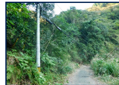
電話局よりケーブルを長距離敷設
