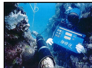
断線した海底ケーブルを復旧
