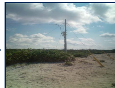
台風によって損傷した陸揚げ柱・端子盤を復旧
