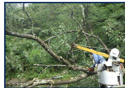
ケーブル裂断防止のため 定期的な樹木剪定等が必要
