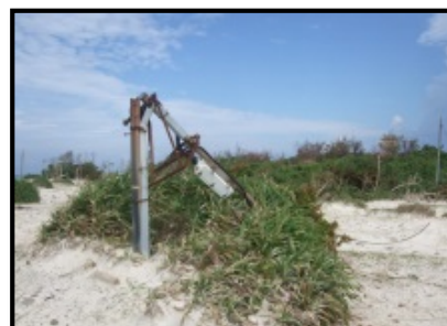
台風によって損傷した陸揚げ柱・端子盤を復旧
