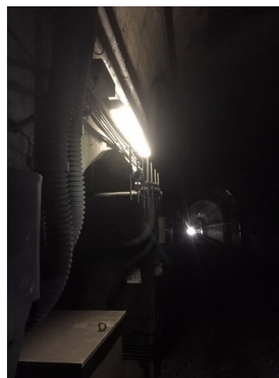
限られた機器設置箇所 他設備の設置 (秋田新幹線)
