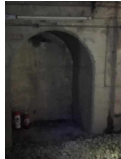
トンネル内退避坑 (機器設置候補一例)
