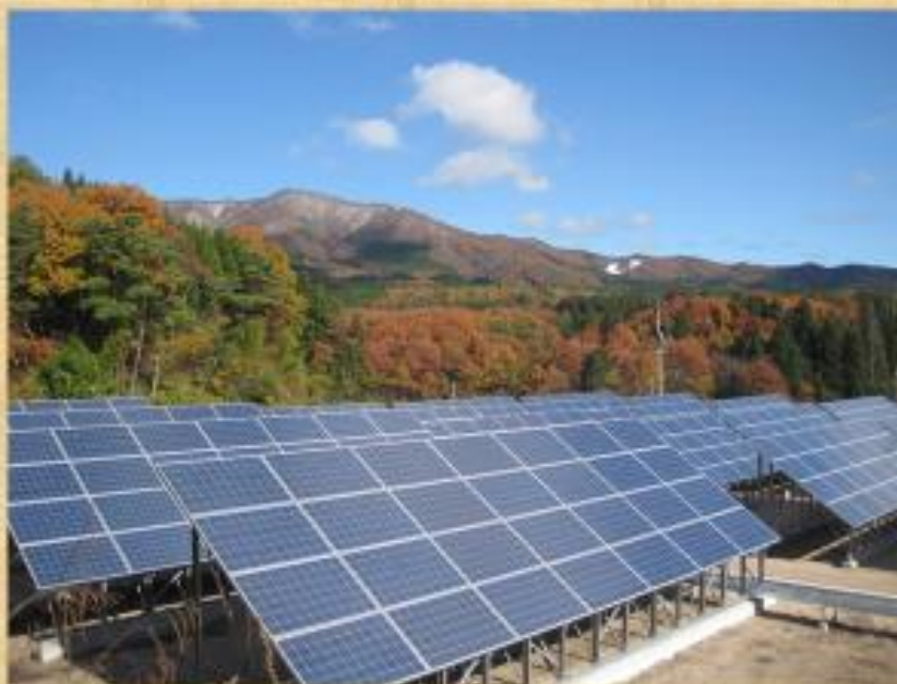
現在:太陽光発電施設
