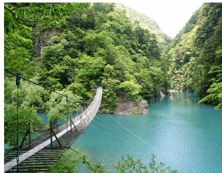
寸又峡 夢の吊橋
