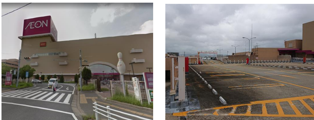
図 3-13 送信基地局設置場所
