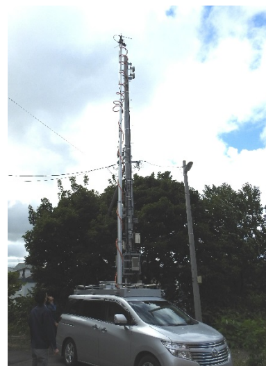
調査中の様子
