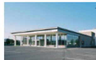
清里町町民会館
