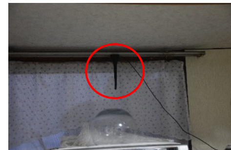
宅内無線ブースターのアンテナ
