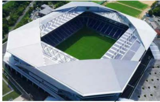
(a) スタジアムの外観
