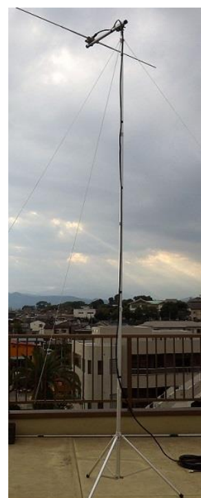
◇組立て後 (アンテナ)
