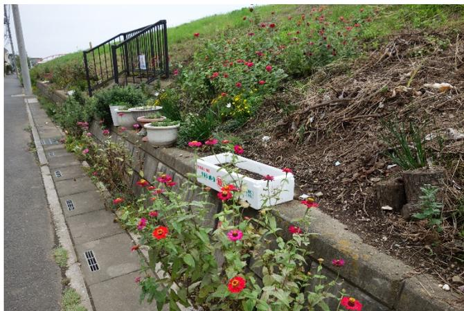
中川左岸堤防の法面に掘削を伴う植栽が行われており、堤体が損傷を受けるおそれ
