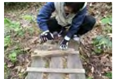
▲施設の補修状況
