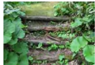
▲木製階段の老朽化
