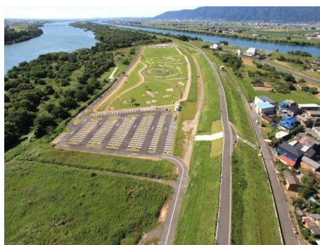
桜堤サブセンター「高水敷エリア」(近景)
