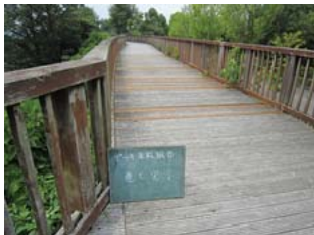
アセットマネジメントによる園路デッキの補修
