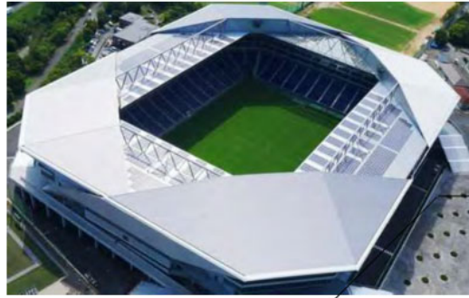
(a) スタジアムの外観
