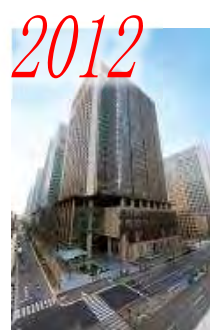
丸の内 永楽ビル
