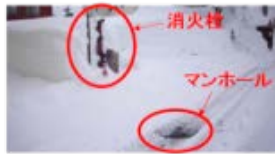
除雪時の雪に隠れた道路設備の保全
