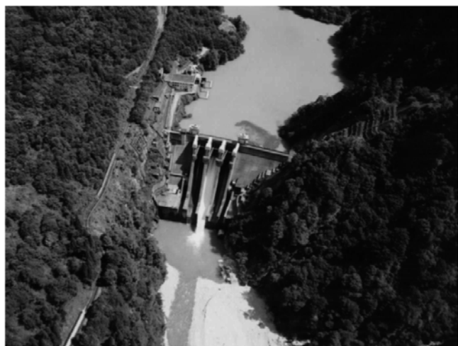
【排砂中の出し平ダム】
