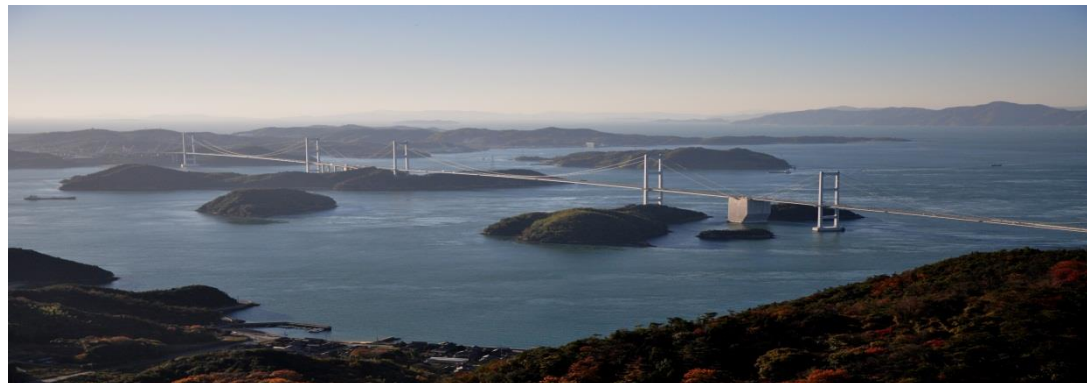
来島海峡大橋
