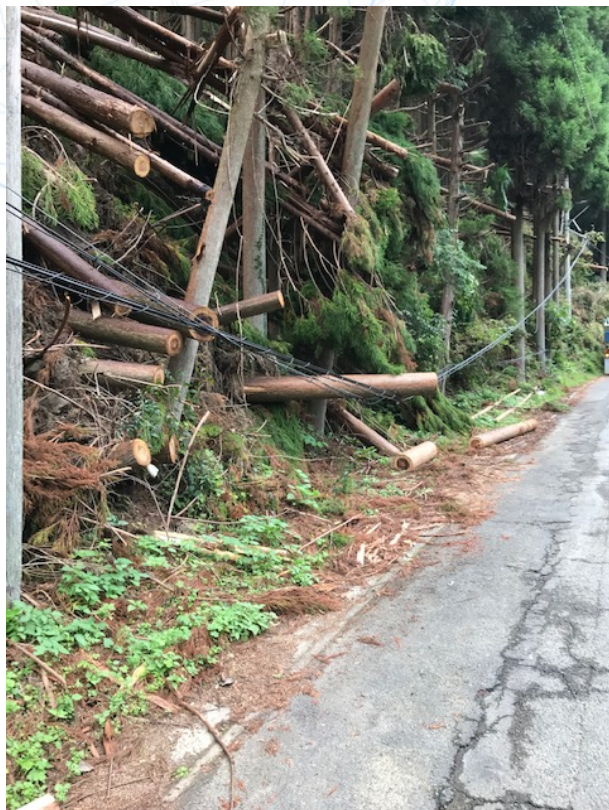
ケーブルに樹木が傾倒
