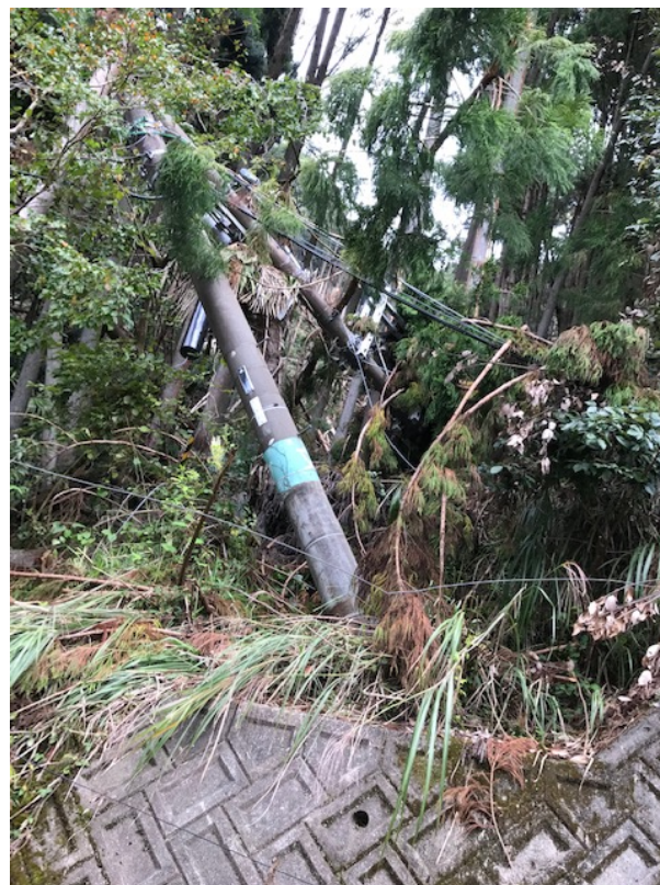
電柱が山側に倒壊
