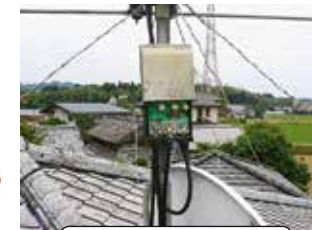
経年劣化したブースター
