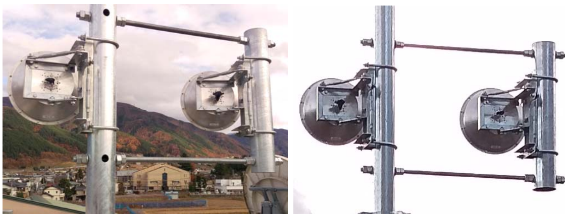
図 4-40 アンテナ取付状況 (左: 親局 (1次) 側 右: 子局 (2次) 側)
