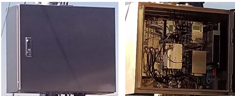
図 3-18 測定用子局（2次）側（左：外観 右：筐体内）
